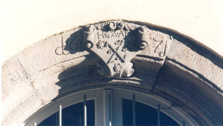
Fenêtre de la Résidence St Joseph donnant dans la rue Principale
