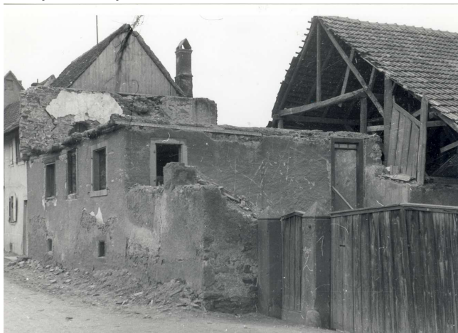
Maison sise au 36 rue du Fossé, endommagée à la libération le 5 février 1945
