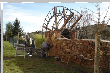
Réhabilitation de la roue à aubes
