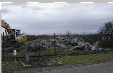
Démolition du bunker
