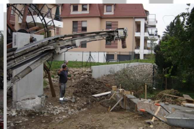
Travaux site roue à aubes
