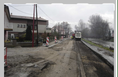
Travaux rte de Ste Croix en Plaine
